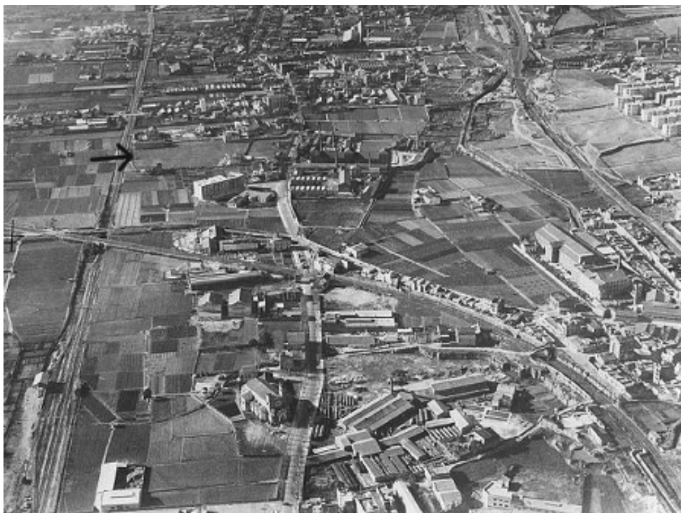
El solar on es van construir els blocs, entre el Carrilet i la carretera. Es poden veure els edificis abandonats i la casa habitable (Arxiu Municipal de l'Hospitalet)
