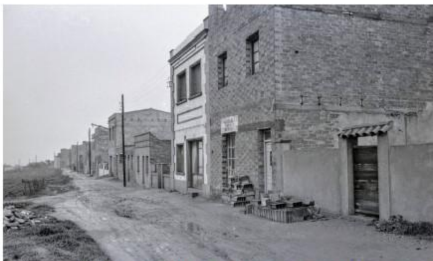
Foto 09. Carrer de Sanfeliu vist des de l'Avinguda de l'Electricitat Arxiu Municipal. AMHLA Fo151948 / a. Company Fotògraf / d. Germans Company Prats
