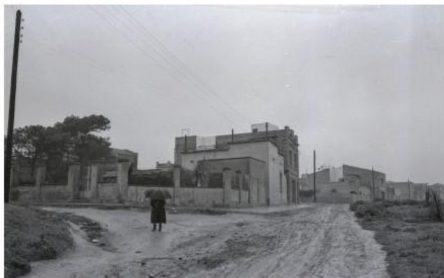
Foto 08. Carrer de Sanfeliu cantonada amb carrer de Miralta Arxiu Municipal. AMHLAFO151949 /a.Company Fotògraf /d.germans Company Prats
