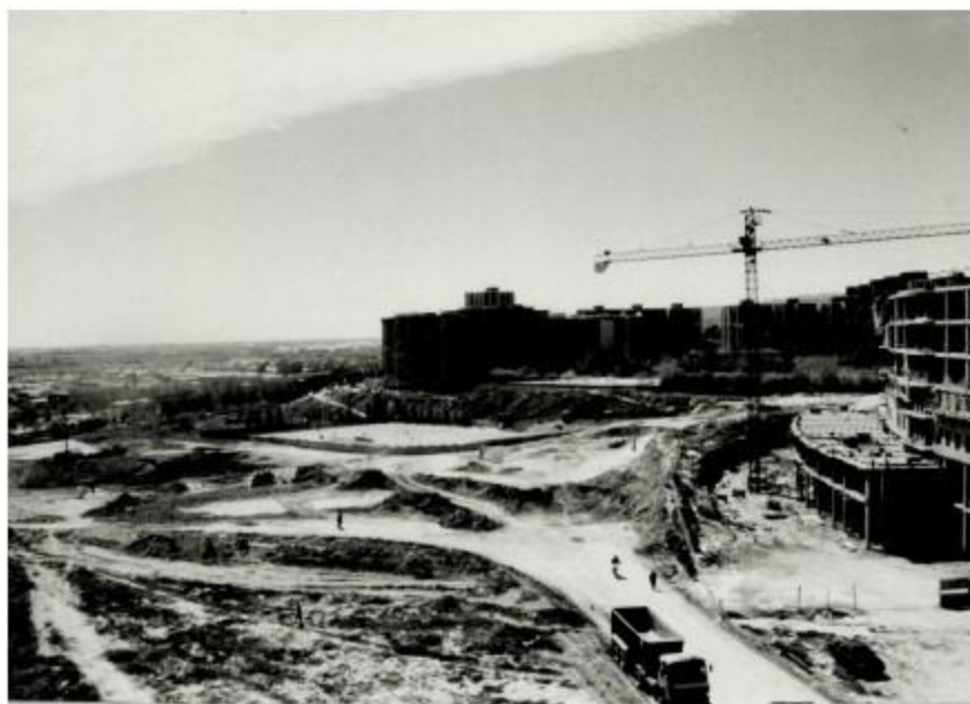
Foto 45. La Ronda i l'edifici del Passeig dels Cirerers en construcció. Arxiu Municipal./MHLA Foo26888
