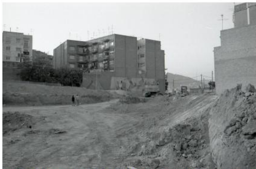
Foto 44. La Ronda en construcció amb l'edifici del carrer de Sanfeliu al fons. /a. Grup Foto Viva
