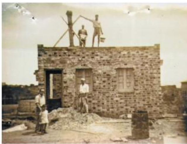
Foto 13. Construcció del carrer de Rubidí, 4. Any 1958 Arxiu Municipal. AMHL_101_C411_1958_00810_0001_FOTO
